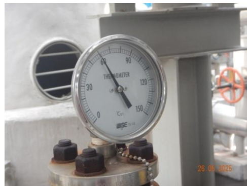
รูปที่ 3-67 อุปกรณ์วัดอุณหภูมิ (Temperature Indicator) ที่ตั้งเก็บกัก
