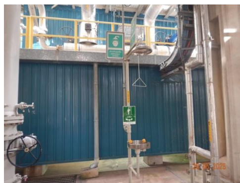
รูปที่ 3-56 อ่างล้างตา สักบัวล้างตา และที่ชำระล้างฉุกเฉิน
