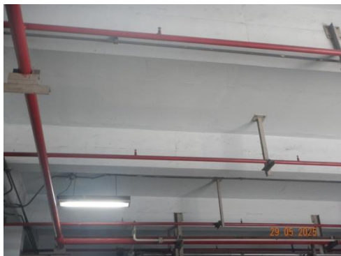
รูปที่ 3-45 ระบบกระจายน้ำดับเพลิง (Fire Water Spray) สำหรับอาคารสำนักงาน และห้องปฏิบัติการวิเคราะห์
