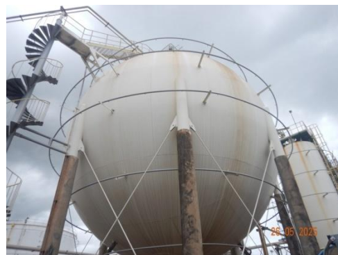
รูปที่ 3-44 ระบบโปรยน้ำดับเพลิง (Fire Water Sprinkle) สำหรับดับเพลิงและหอกัน
