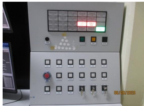
รูปที่ 3-10 Emergency Shutdown Push Button Switch ที่ห้องควบคุมกระบวนการผลิต
