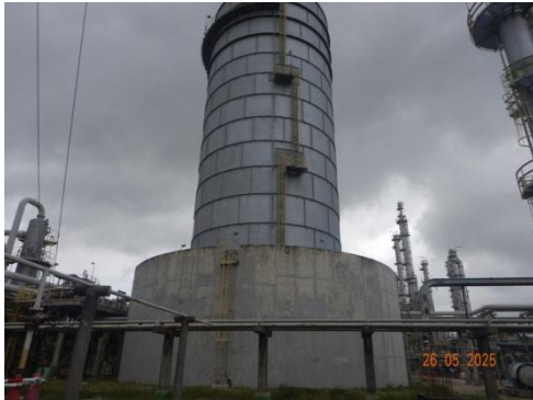
รูปที่ 3-6 หอเผาทั้งระดับพื้นดินแบบมิดชิด (Enclosed Ground Flare)
