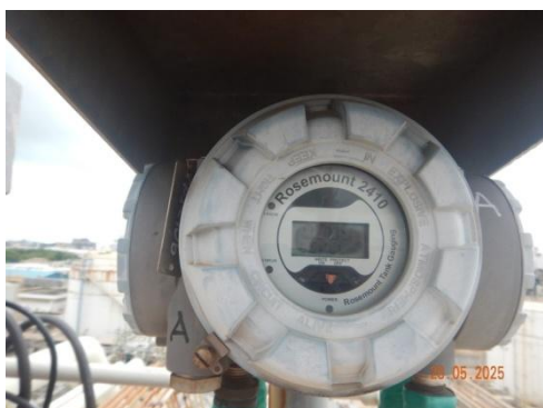
รูปที่ 3-68 อุปกรณ์วัดระดับ (Level Indicator) ที่ตั้งเก็บกัก
