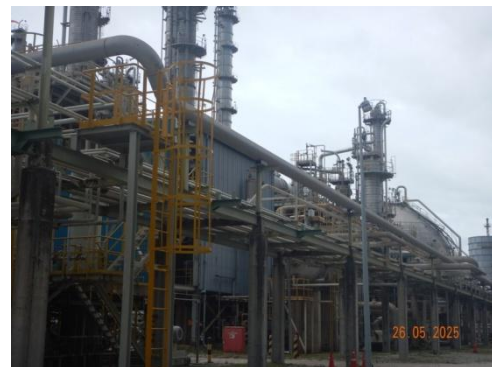
รูปที่ 3-63 ท่อส่งไอสารส่วนเกินที่ห่อเผา (Flare)
