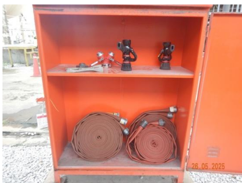
รูปที่ 3-55 Fire Water Nozzle
