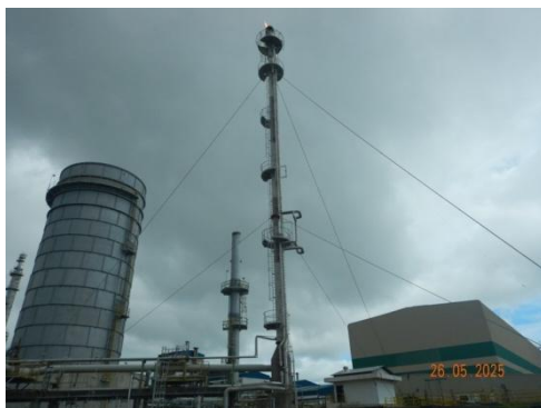
รูปที่ 3-5 หอเผาที่ระดับเหนือพื้นดิน (Elevated Flare)
