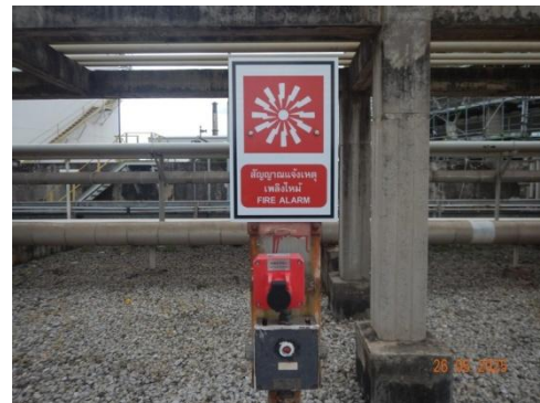
รูปที่ 3-52 Fire Alarm Manual System
