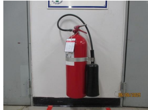
รูปที่ 3-48 ระบบดับเพลิง CO 2 สำหรับห้องสายไฟ
