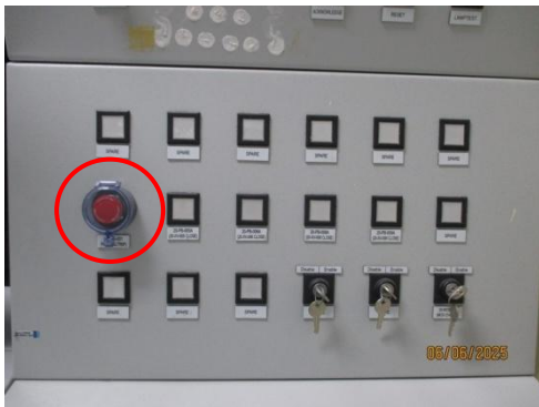
รูปที่ 3-7 Instrument Shutdown System (ISD)
